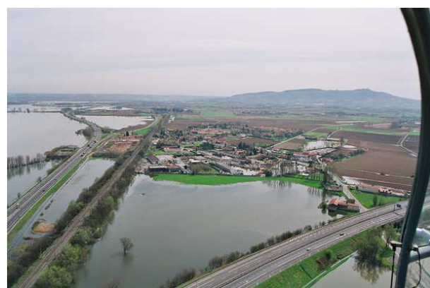
Ambérieux, crue de 2001
