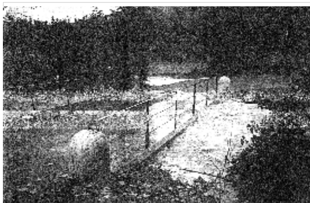
mise en charge du pont de l'Ozon
