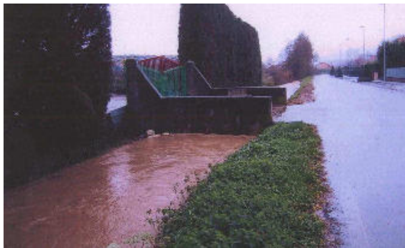
crue de novembre 2002 sur l'Inverse à Simandres – l'Inverse en limite de débordement dans le centre ville
