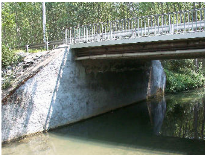
ouvrage principal sous la déviation de la RN 7 - vue depuis l'amont de l'ouvrage et du remblai
