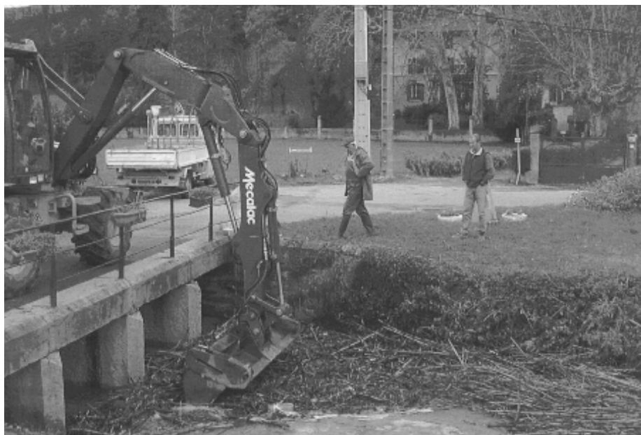
Travaux d'enlèvement des embâcles après la crue de novembre 2002 au niveau du pont sur l'Ozon, rue de l'Ozon
