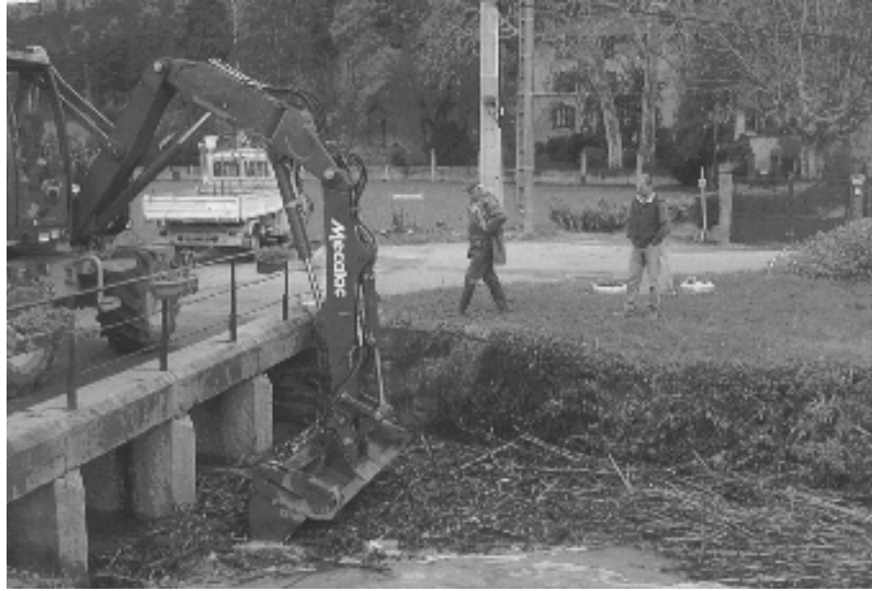
crue de novembre 2002 sur l'Ozon à Sérézin-du-Rhône – enlèvement des embâcles
