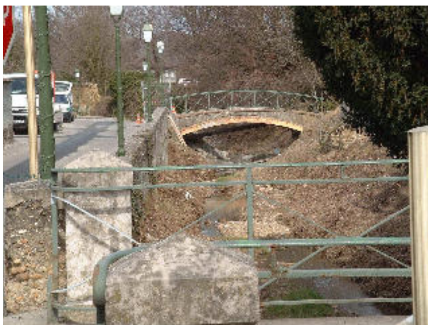
passerelle piétonne sur le ruisseau de Putaret - Chaponnay
