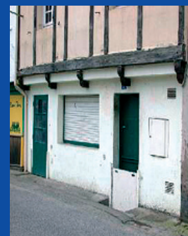
Pose d'un batardeau
