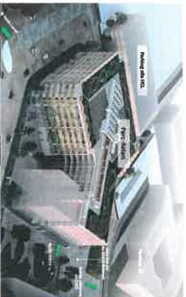
Figure 9 : Vue axonométrique de la station de métro avec le parc-relais situé au-dessus (source : SYTRAL)
