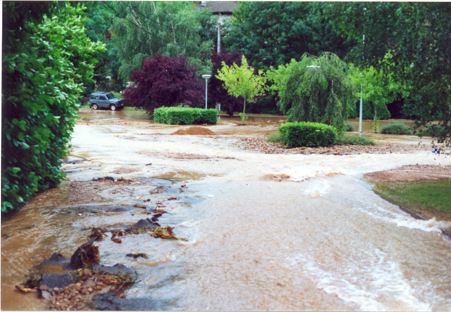
Juin 2000 Inondation du stade par l'Ardières. Coulées de boue et dépôt de gravier, revêtement de chaussée emporté (source : Étude HYDRATEC 2005)
