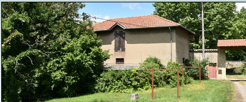
La ferme de la Morelle – photo SMPMO 2018
