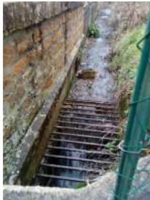
La réponse du maître d'ouvrage est la suivante : *La grille de l'ouvrage d'entonnement présent au droit du 1952 Route des Monts d'Or sera remplacée de manière à favoriser les écoulements et à limiter les embâcles. Elle sera positionnée de manière inclinée pour permettre l'écoulement des eaux même en présence de branches et de feuilles dans le ruisseau. Ces embâcles resteront en surface, sur le haut de grille (grille similaire à celle présente en amont du stade).*
