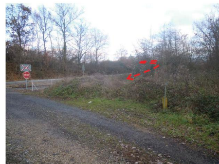
Figure 14 : Vu du cheminement de l'ouvrage d'art de franchissement des voies ferrées depuis le chemin communal
