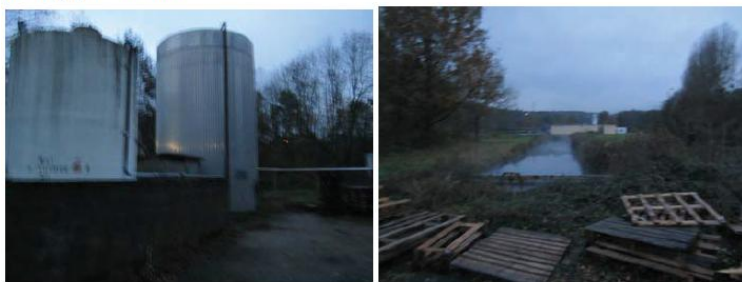
Figure 11 : Vue des installations sud de Mathelin
