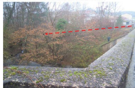
Figure 10 : Vue sud depuis le pont de franchissement de l'Azergues de l'ouvrage en dénivelée à créer
