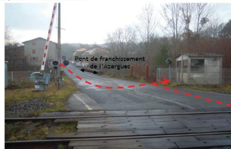
Figure 9 : Vue de l'accès depuis le nord du PN 66
