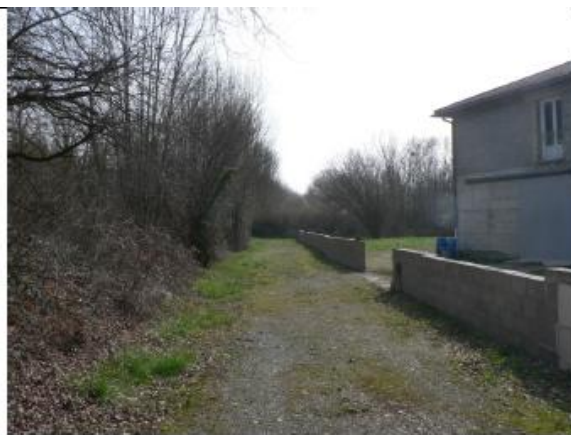
2- Tronçon 2 – Reprise du chemin existant
