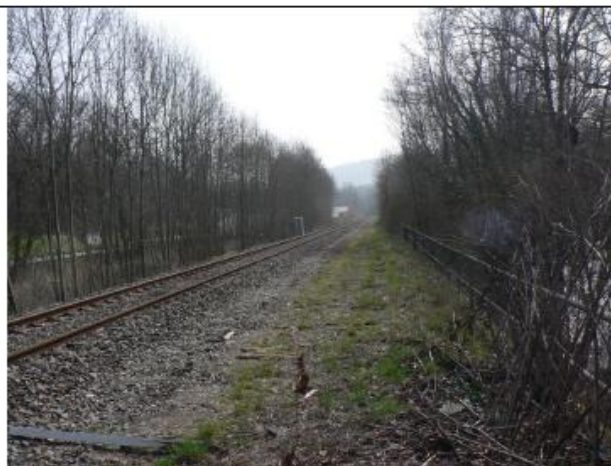
5- Tronçon 4 – Réutilisation de la plate-forme ferroviaire existante
