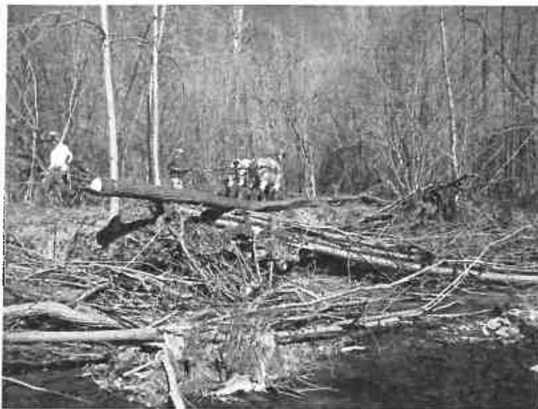
Réalisation d'un piège à matériaux sur l'Yzeron à Vaugneray en mars 2009 (Alternative débardage)
