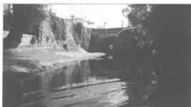
Pont du Cheval blanc (vue amont)
