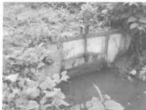
Vanne de décharge rive gauche (septembre 2012)
