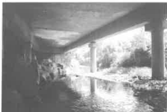
Banquette de la RN7 dans la continuité du pont du Cheval blanc
