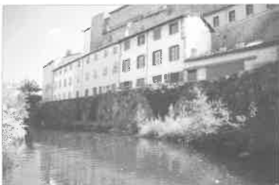
Mur de soutènement du Quai des frênes
