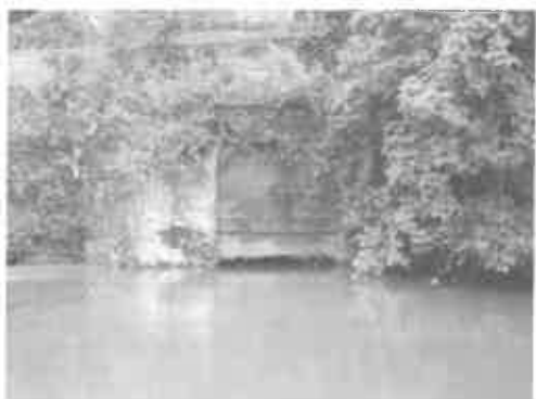
Vanne de prise d'eau (septembre 2012)
