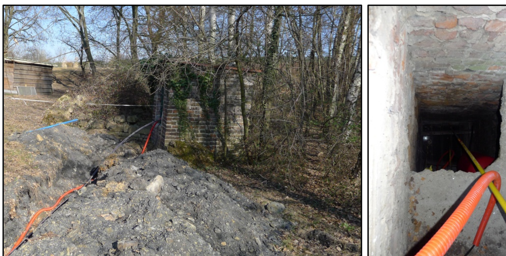
Site du puits BAYETTAN. Maçonnerie sur l'orifice du FAUX-puits à eau
