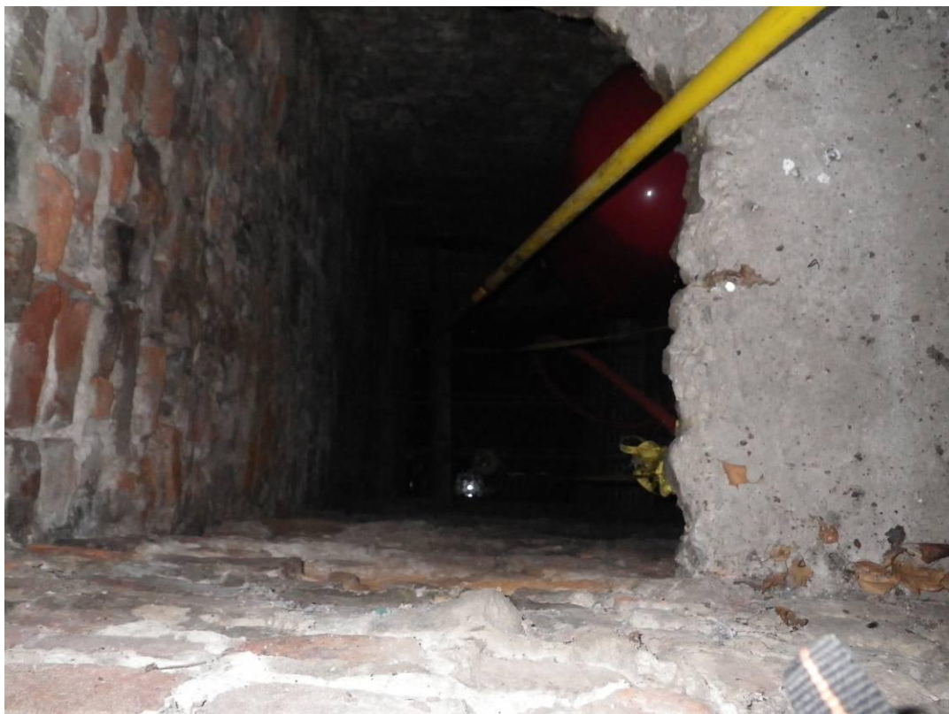
Photo 6 : dalle percée et colonne vide du Faux-Puits
