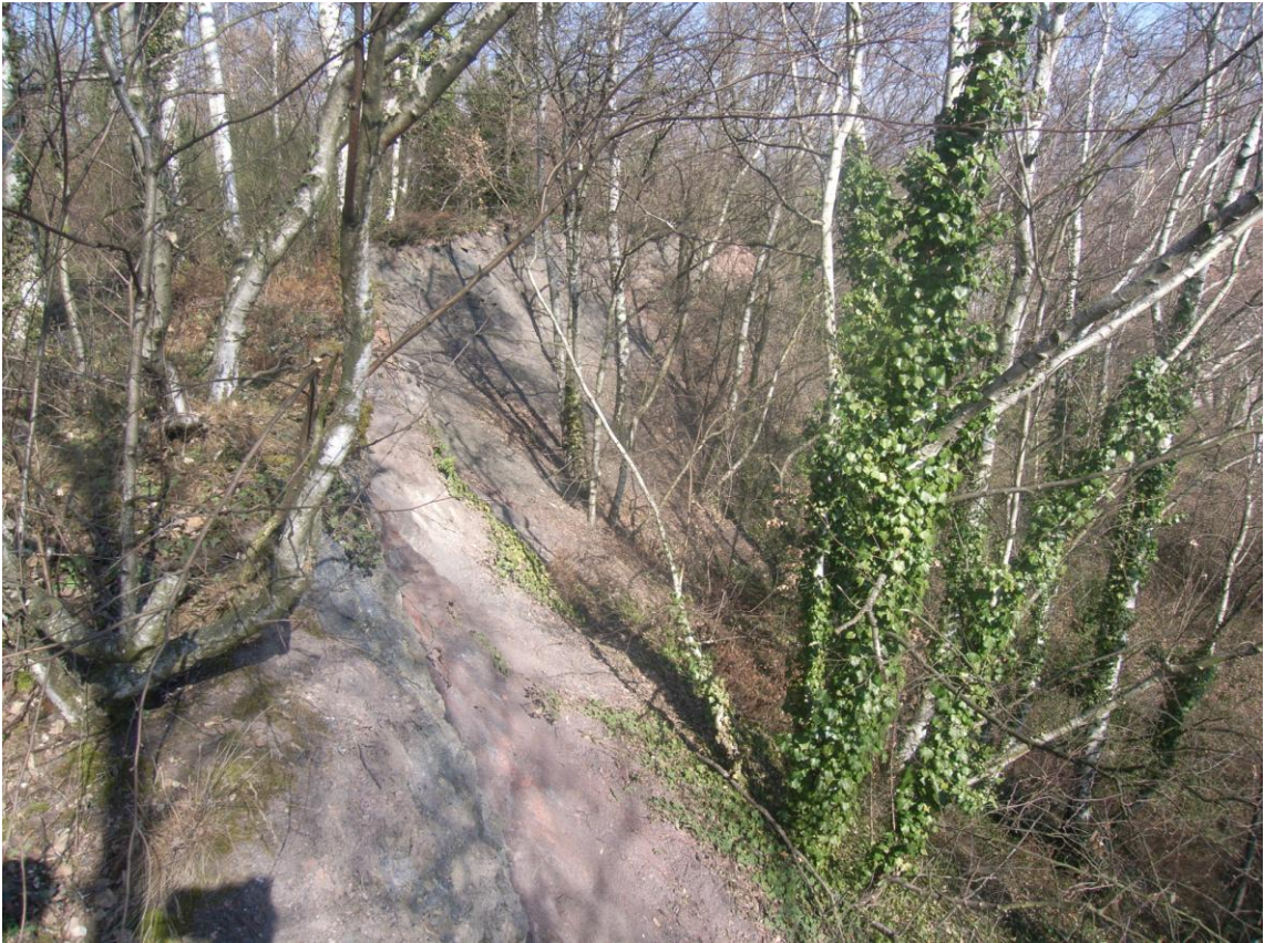
Photo 19 : prise de remblais en bordure du terril de l'Espérance
