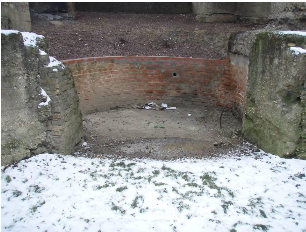
Photo 8 : tête du puits de l'Espérance après traitement.
