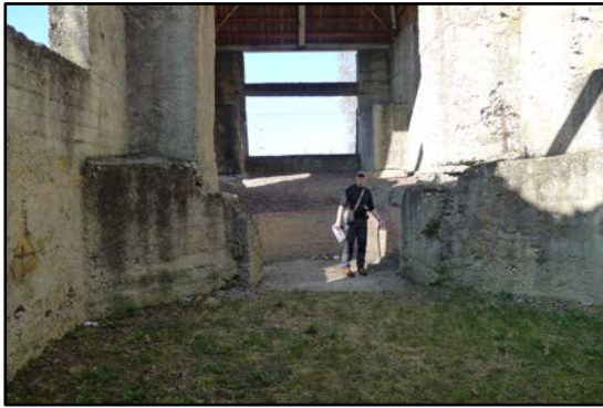
Puits de l'ESPERANCE
