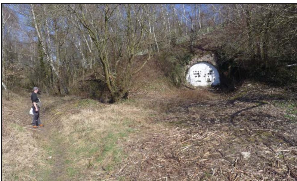
Tunnel sous le terril de l'ESPERANCE. Entrée Ouest murée.
