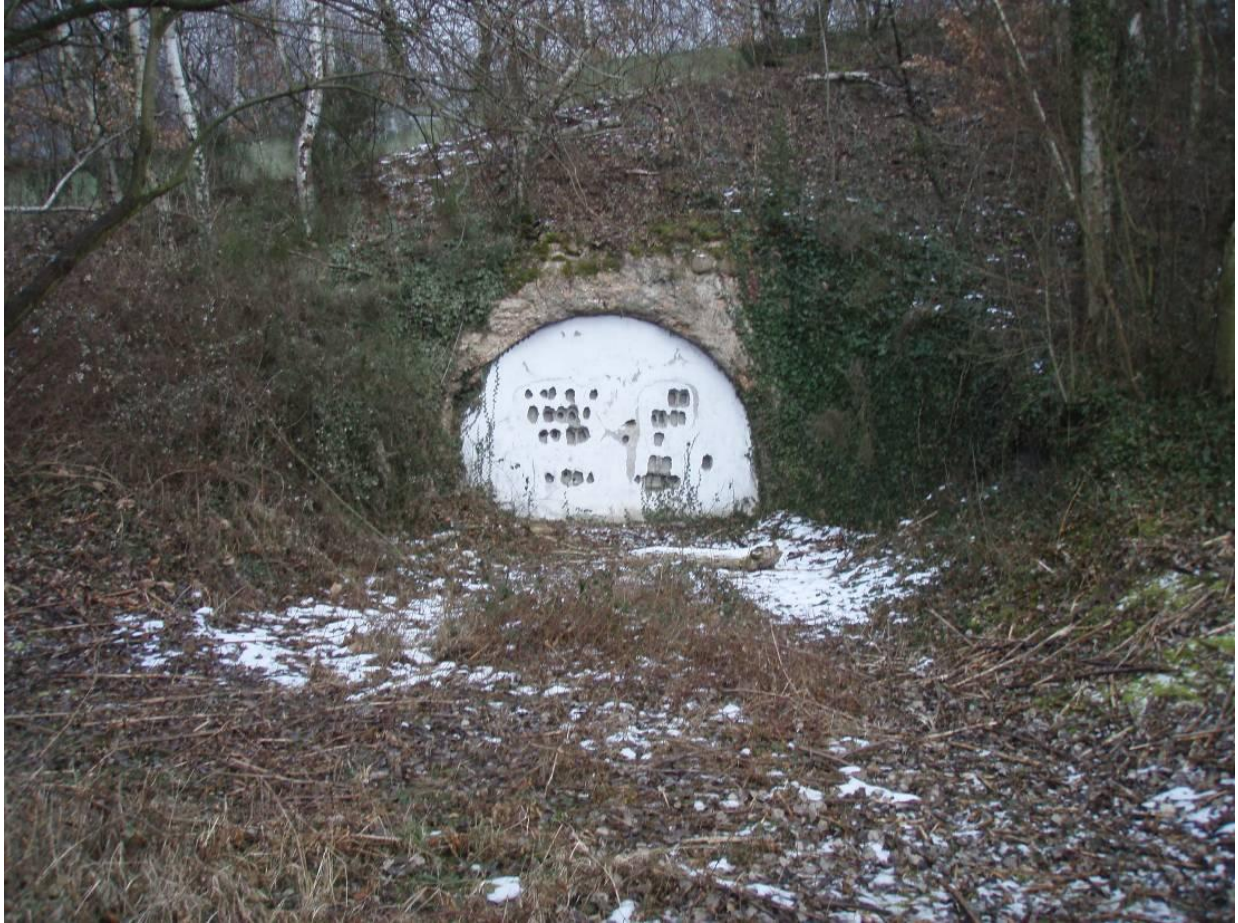
Photo 15 : entrée murée ouest de la galerie sous le teruil de l'Espérance.
