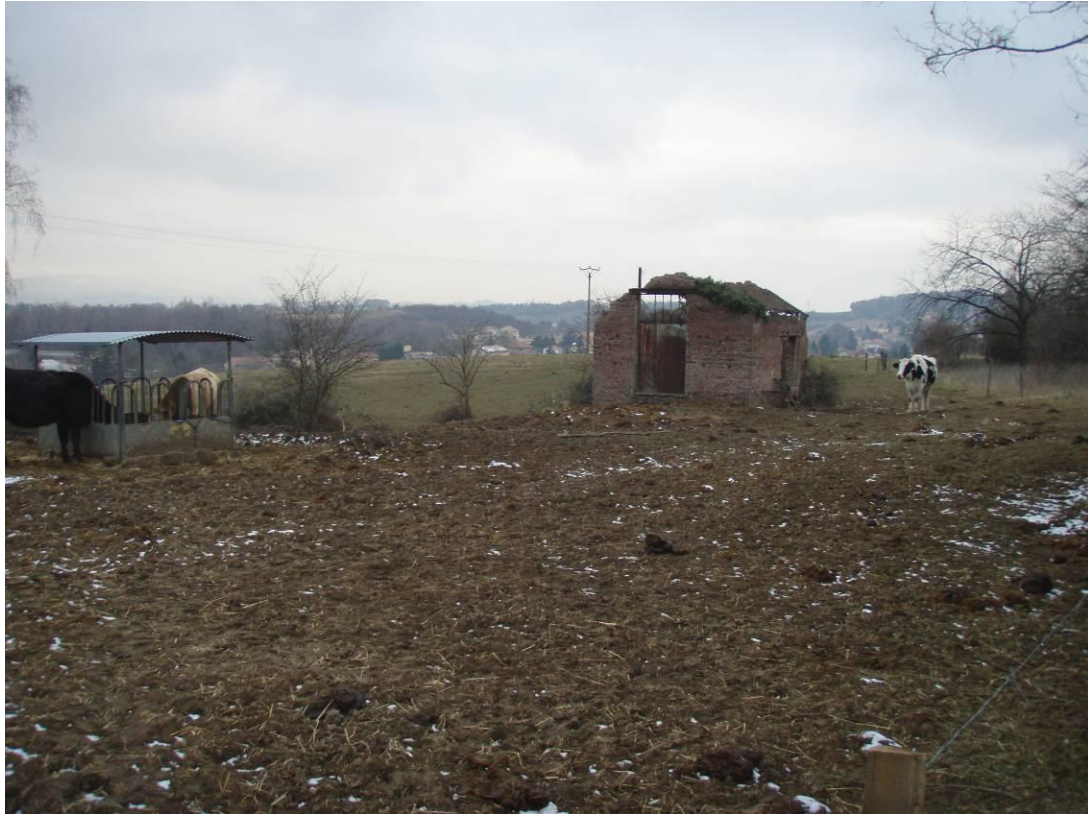
Photo 4 : reste du bâtiment de la machine du puits Guérin.
