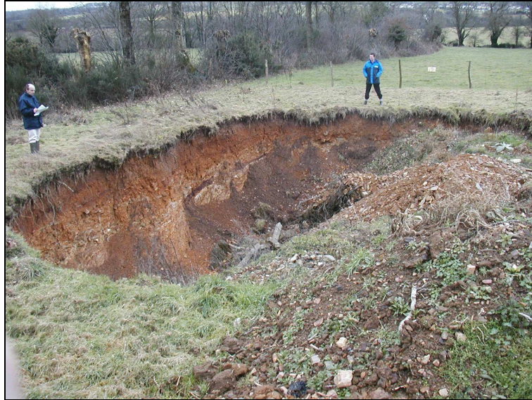
Effondrement localisé de grande dimension
