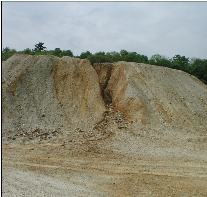
illustration 18 - Erosion sur les flancs du Terril Perret
