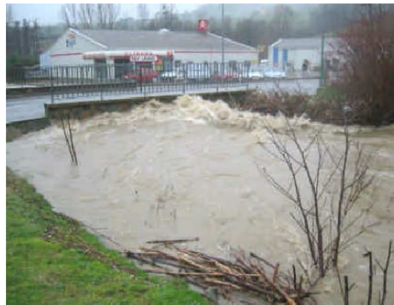
Pont d'accès à la Zi du Mortier à Pontcharrasur Turdine, en 2003 Source SYRBT
