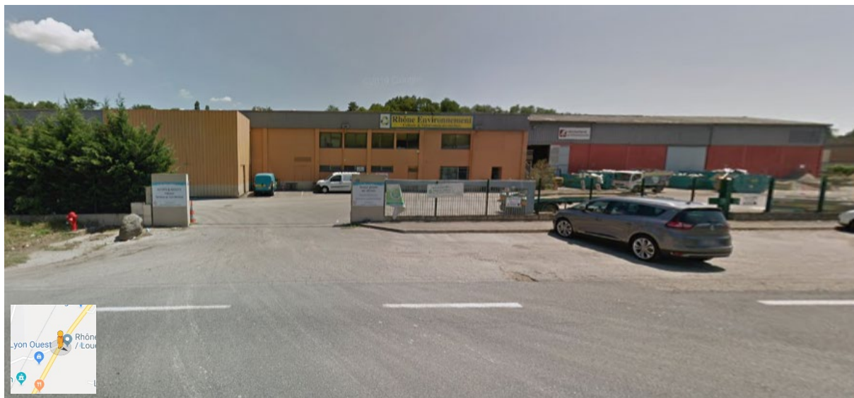
Figure 1: Vue de l'avant du site de Rhône environnement (prise le 27 juin 2019 depuis la route de Brignais)
