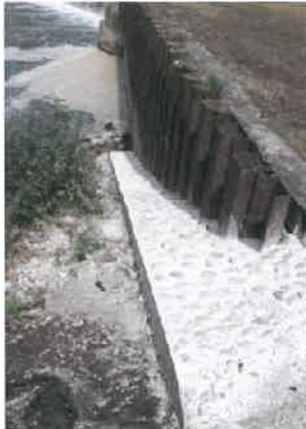
Figure 26 : Exemple de rampe béton avec galets
