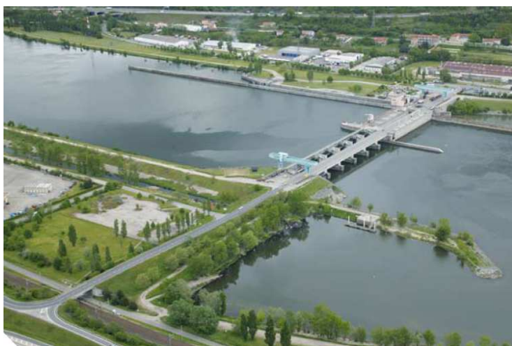
Aménagement de Vaugris (© Wikhydro)
