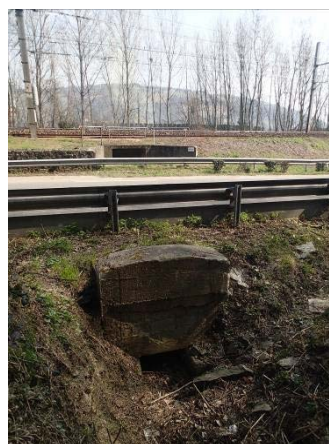
2. Ouvrages sous la RN86 et la voie ferrée
