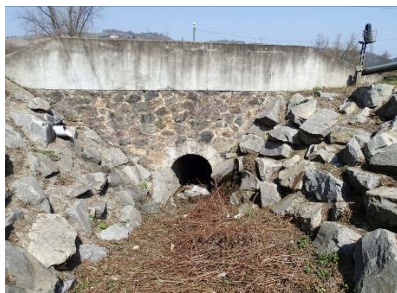
5. Ouvrage sous la RN86 et la voie ferrée
