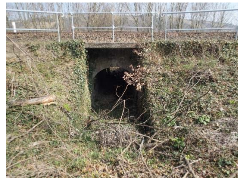
2. ouvrage sous la voie ferrée
