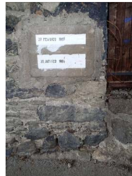
2. Repères de crues
