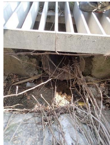
2. Détail de l'ouvrage (amont)
