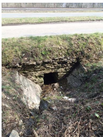
1. Ouvrage sous la RN86 et la voie ferrée
