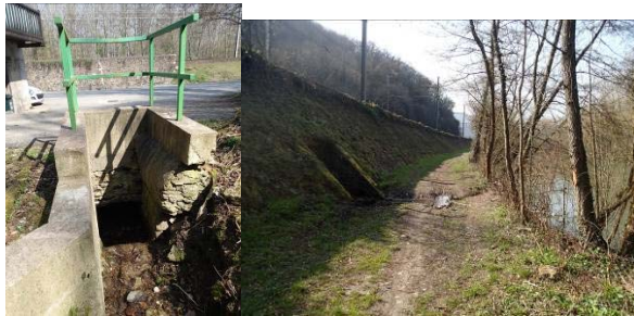
1. Ouvrage sous la RN86 et la voie ferrée
