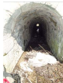
6. Ouvrage sous la RN86 et la voie ferrée
