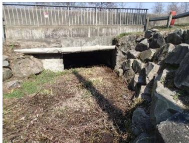
3. Ouvrage sous la RN86 et la voie ferrée
