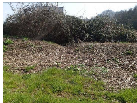
4. Merlon rive gauche à proximité de la voie ferrée
