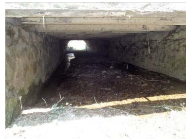
4. Ouvrage sous la RN86 et la voie ferrée
