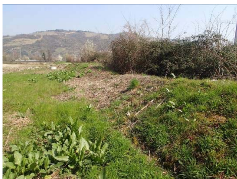
3. Merlon rive gauche
