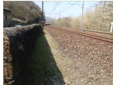
2. Muret séparant la RN86 et la voie ferrée
