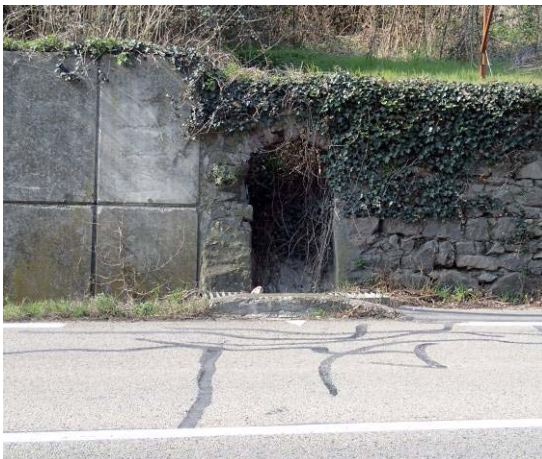
1. Franchissement RN86 et voie ferrée
