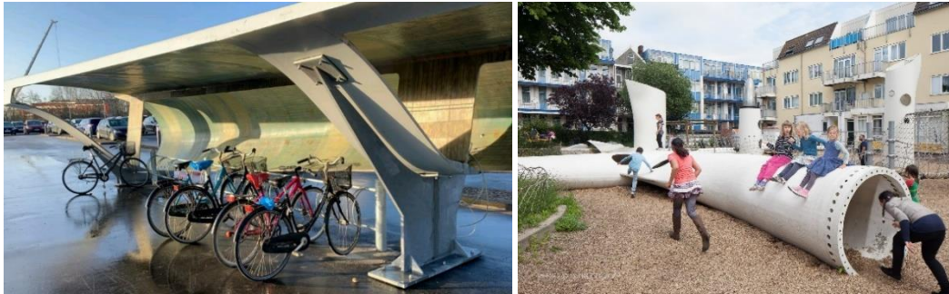
Figure 1 : Exemple de réutilisation de pales d'éoliennes
