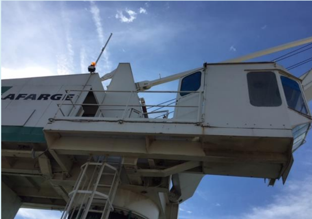
Grue portuaire sur le site de CSL Saint-Fons
