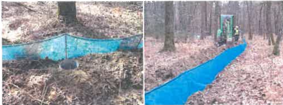
Mise en œuvre de la barrière-piège pour les amphibiens (source : BHO/TOPEO)
