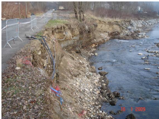
Figure 78 : Gier - Erosion de berge et passerelle, au hameau de la Fléchette
