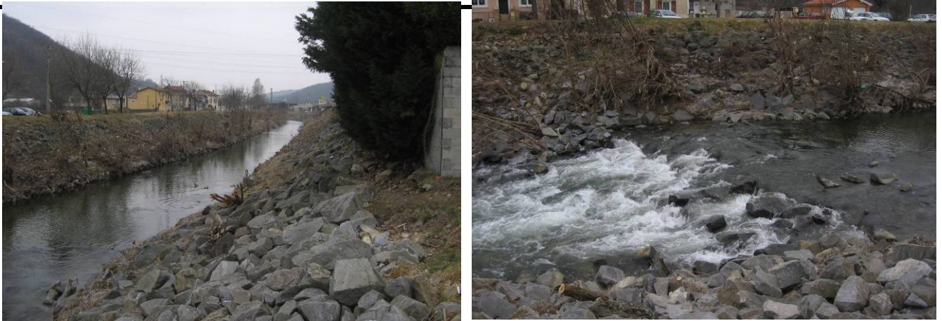
Figure 87 : Gier – Secteur endigué amont avec série de seuils
