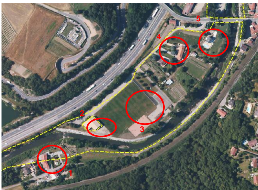
Figure 79 : Gier - Zone amont de Saint Romain avec contour de la crue de 2008
