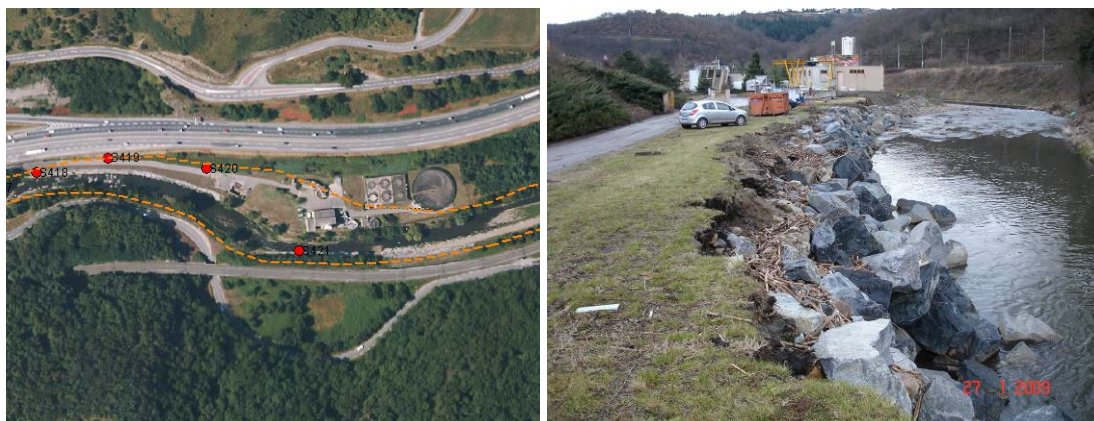
Figure 75 : Gier - Emprise de la crue de 2008 (à gauche) et vue de la STEP (à droite) où le niveau est monté jusqu'à mi hauteur de la voiture
