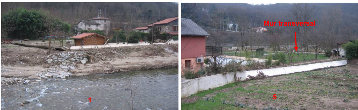
Figure 80 : Gier – Murs ayant basculé à St-Romain
