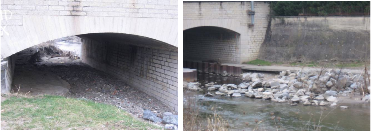
Figure 91 : Gier – Pont SNCF de la ligne St-Etienne-Lyon
