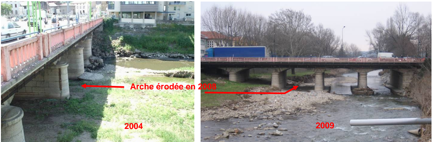
Figure 93 : Gier – Pont des Fainéants à Givors
