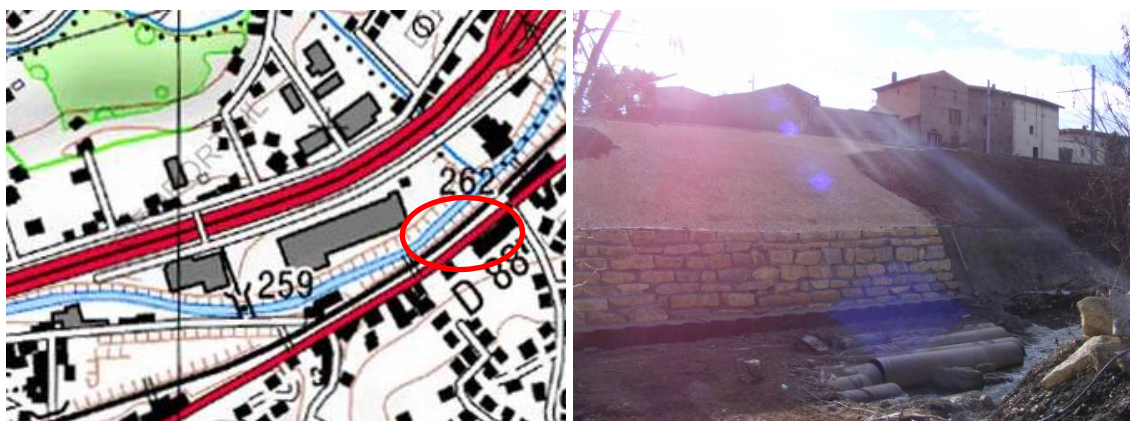
Figure 71 : Gier - Confortement du talus SNCF
