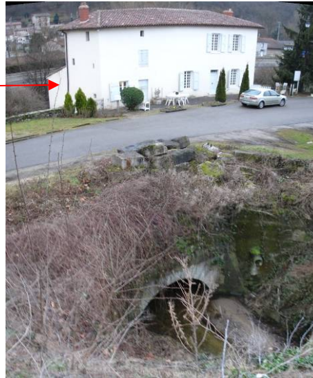
Figure 61 L'ouvrage sous le chemin communal
