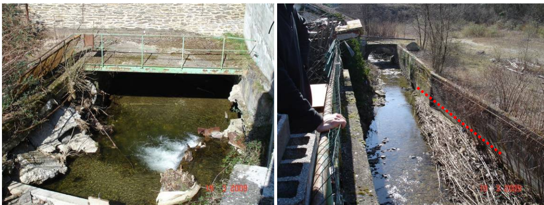
Figure 40 : Le Couzon - Couverture du Couzon (photo de gauche) et vue vers l'amont depuis la couverture avec le niveau approximatif atteint en 2008 (photo de droite)
