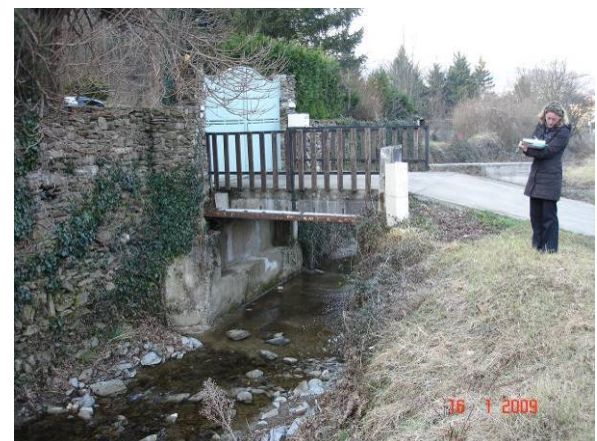
Figure 67 Ouvrage d'accès privé(2)
