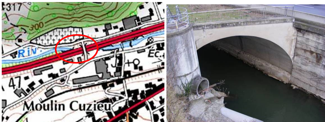
Figure 70 : Gier - Ouvrage sous l'A47
