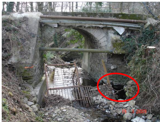
Figure 45 : Le grand Féloin - Ouvrage du chemin de saint martin
