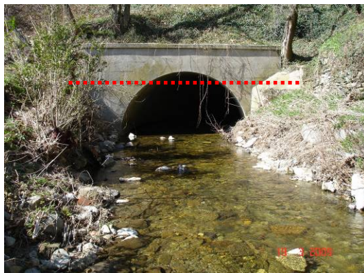
Figure 39 : Le Couzon - Couverture des tennis avec le niveau atteint en 2008
