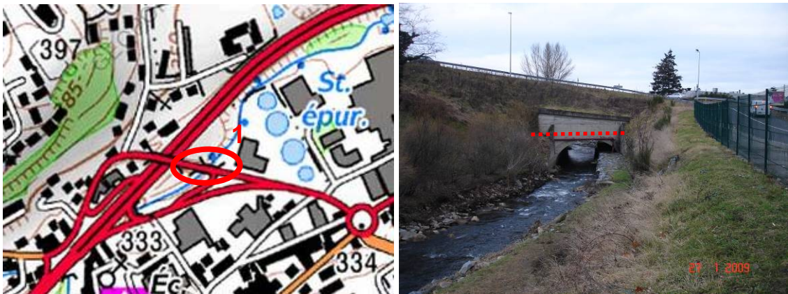
Figure 69 : Le Gier - Ouvrage à l'amont de la STEP de Saint Chamond
