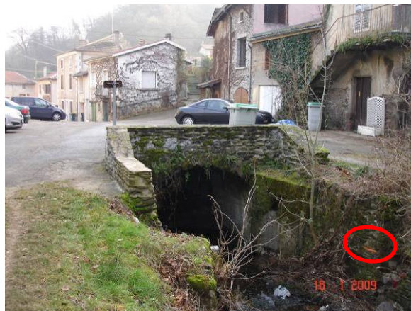
Figure 53 : Le Lozange - Entrée de la couverture de Dargoire (1)
