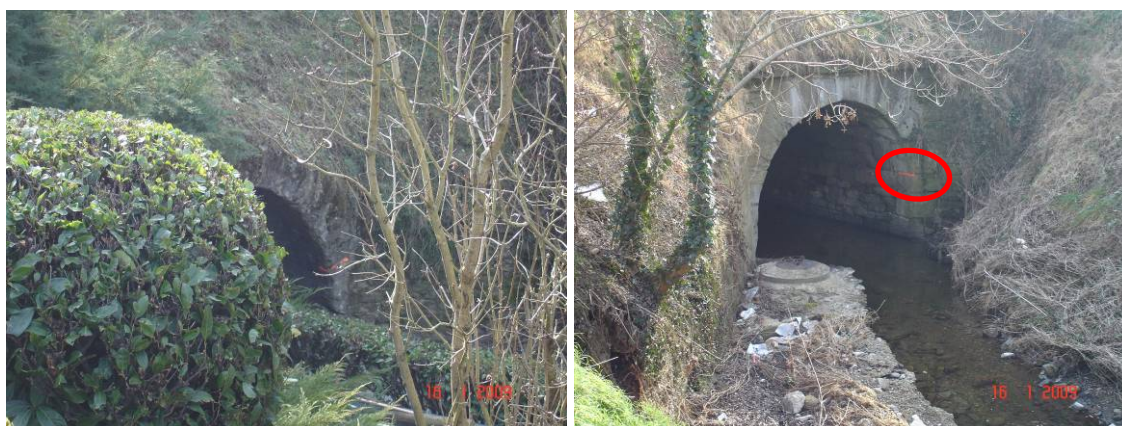
Figure 58 : Le Lozange - Amont de l'ouvrage des carrières (à gauche) et de l'ouvrage de la Roche trouée / RD488 (à droite). Repères de crue de 2003 en orange
