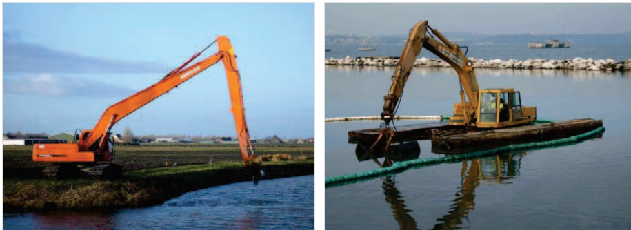
Figure 5 : Photos d'une pelle mécanique bras long et amphibie en action
