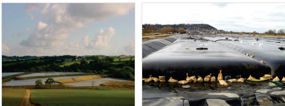
Figure 7 : Exemple de prétraitement en bassin de décantation sur parcelle agricole ou géotextile filtrant
